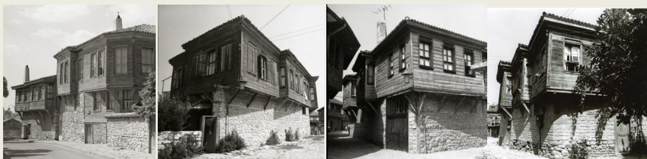
Сгради представители на народната архитектура; Снимки 1985 г.; Източник: НДАФ на НИКН
